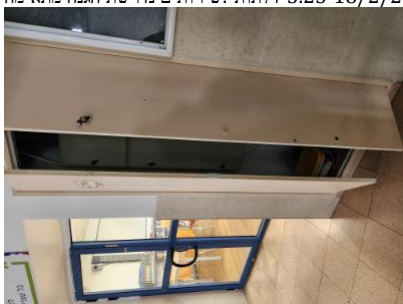
מבנה הראל - ליד הספרייה. -לוחות החשמל ללא סידורי נעילה מתאימים. מפסקי החשמל בהישג ידם של תלמידים- - - יהיו סידורי נעילה. לא יהיו חלקים חשופים בלוחות. לא יהיו ארונות חשמל לוחות חשמל לא יהיו עשויים מחומרים דליקים, הארונות יהיו סגורים וללוחות-1-מפגע גורף בצמוד לכיתות, מעבדות, משרדים וחדרי ספח מאוכלסים 9-1-18/2/2023 6:44-לוחות חשמל-(ראשי/קומתי ואגפי)
