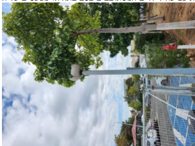
חצרות מוסד החינוך. מספר-גופי תאורה ישנים - על עמודים גבוהים, ללא מכסה/ כיסוי שלם. סכנת התחשמלות- - - 9-7-18/2/2023 6:37-מנורות גופי תאורה-גופי התאורה בחדרי השירותים ובחצר יהיו מטיפוס מוגן-מים-1-מוקדים
