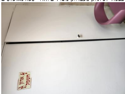
מבנה הראל - ליד הספרייה. -לוחות החשמל ללא סידורי נעילה מתאימים. מפסקי החשמל בהישג ידם של תלמידים- - - יהיו סידורי נעילה. לא יהיו חלקים חשופים בלוחות. לא יהיו ארונות חשמל לוחות חשמל לא יהיו עשויים מחומרים דליקים, הארונות יהיו סגורים וללוחות-1-מפגע גורף בצמוד לכיתות, מעבדות, משרדים וחדרי ספח מאוכלסים 9-1-18/2/2023 6:44-לוחות חשמל-(ראשי/קומתי ואגפי)
