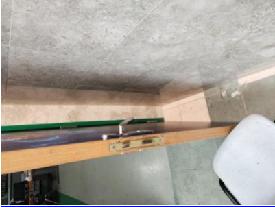
-יסטופר לא תקין/ קיים בדלת הכניסה של מעבדה ה'. מגן אצבעות לא מותקן בדלת המעבר בין שתי המעבדות ליד מעבדה א- - - הדלתות תצוידנה באבזר או באבזרים לצורך המטרות הבאות: א. מגן אצבעות בשני צידי הצירים באזורים שבהם יש אפשרות להילכדות אצבעות. ב. האטת 1-מעבדה ה'. מעבדה א אגף הדלת במהלך סגירתו. ג. מעצור דלת במצב פתוח. האבזר יותקן בקיר, בגובה אגף הדלת ולא ברצפה. ד. במקלט ובמרחב מוגן יש להתקין מגן אצבעות ואלמנט קיבוע שיותאם לדלת. 5.23-17/2/2023 13: 28 דלתות קלות של שירותים נדרשת הגנה מתאימה ה. בדלתות קלות של שירותים נדרשת הגנה מתאימה
