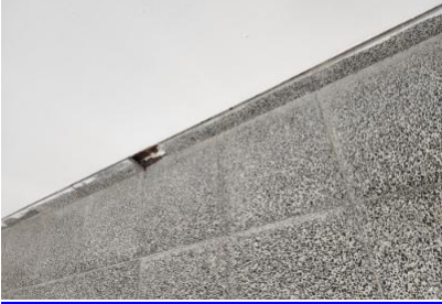
לא יהיו מפגעי 2-אולם ליד חדר מנהלת/ מעבדה ה-פנלים בין רצפה לקירות מתפרקים. מרצפות שבורות בכניסה למעבדה ה- - - 5.10-17/2/2023 13: 22 מפגעים קבועים וניידים.- תשתית בבניין ובכיתות ובפרט סדקים במבנה, רצפות שקועות, סימני רפיון (כגון "בטון") בתקרות תלויות ומפגעי תשתית אחרים
