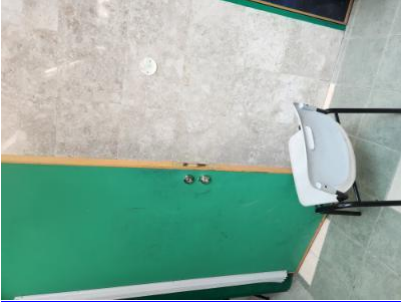
-יסטופר לא תקין/ קיים בדלת הכניסה של מעבדה ה'. מגן אצבעות לא מותקן בדלת המעבר בין שתי המעבדות ליד מעבדה א- - - הדלתות תצוידנה באבזר או באבזרים לצורך המטרות הבאות: א. מגן אצבעות בשני צידי הצירים באזורים שבהם יש אפשרות להילכדות אצבעות. ב. האטת 1-מעבדה ה'. מעבדה א אגף הדלת במהלך סגירתו. ג. מעצור דלת במצב פתוח. האבזר יותקן בקיר, בגובה אגף הדלת ולא ברצפה. ד. במקלט ובמרחב מוגן יש להתקין מגן אצבעות ואלמנט קיבוע שיותאם לדלת. 5.23-17/2/2023 13: 28 דלתות קלות של שירותים נדרשת הגנה מתאימה ה. בדלתות קלות של שירותים נדרשת הגנה מתאימה
