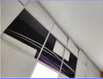
1-י'אולם בקומת קרקע, מעבדה ה-חלקים מתוך התקרה האקסטטית לא תקינים / לא קיימים. סכנת נפילת חלקים מהתקרה- - - 5.10-17/2/2023 מפגעים קבועים וניידים-. לא יהיו מפגעי תשתית בבניין ובכיתות ובפרט סדקים במבנה, רצפות שקועות, סימני רפיון (כגון "בטן") בתקרות תלויות ומפגעי תשתית אחרים 13: 36
