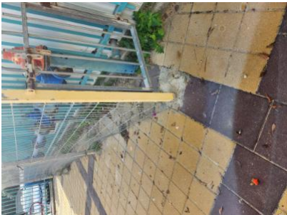
החצר תאורגן באופן שיבטיח בטיחות 1-חצר בית הספר. ליד שער היציאה הדרומי-גדר הגנה לא יציבה על גמל המים. סכנת פציעה- - - 3.11-23/1/2023 20: 50 ארגון החצר-מרבית בעת תנועה ופעילות של תלמידים
