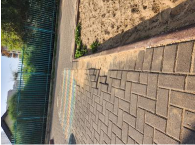
החצר תהיה נקייה ממפגעי 1-חצר אחורית. צמוד למתקן קפיצה לרוחב-מהמורות והפרשי גבהים באבנים המשתלבות . סכנת נפילה- - - 3.1-23/1/2023 20: 37 תשתיות- בטיחות קבועים או זמניים, ללא בליטות או שקעים, ולא יישארו בה מכשולים או פסולת מכל סוג . חלקים בולטים יהיו עם הגנה עליהם
