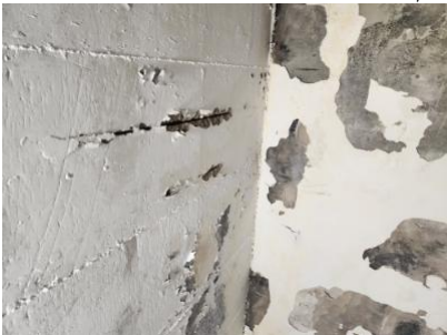
לא יהיו מפגעי תשתית בבניין ובכיתות ובפרט סדקים במבנה, 1-אולם ספורט-רטיבות בחדר הפנימי שבתוך האולם. סכנת תחלואה- - - 5.10-23/1/2023 20: 52 מפגעים קבועים וניידים-רצפות שקועות, סימני רפיון (כגון "בטן") בתקרות תלויות ומפגעי תשתית אחרים
