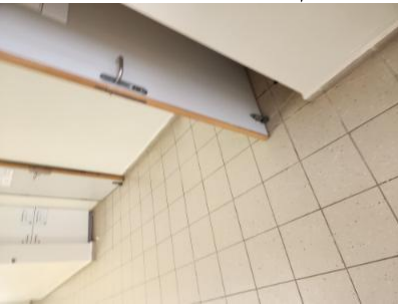
כיתות לימוד - .גלגלון האטה לא תקין. מפגע גורף תפס לא תקין/ קיים. מפגע גורף מנגנון האטה לא תקין בדלת יציאה מחדר אוכל- - - - הדלתות תצוידנה באבזר או באבזרים לצורך המטרות הבאות : א. מגן אצבעות בשני צידי הצירים באזורים שבהם יש אפשרות להילכדות אצבעות. ב. האטת אגף 1-חדרי ספח. מפגע גורף הדלת במהלך סגירתו. ג. מעצור דלת במצב פתוח. האבזר יותקן בקיר, בגובה אגף הדלת ולא ברצפה. ד. במקלט ובמרחב מוגן יש להתקין מגן אצבעות ואלמנט קיבוע שיוותאם לדלת. ה. 5.23-12/2/2023 21: 32-דלתות-.בדלתות קלות של שירותים נדרשת הגנה מתאימה
