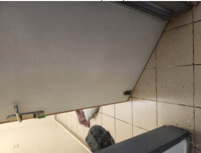
כיתות לימוד - .גלגלון האטה לא תקין. מפגע גורף תפס לא תקין/ קיים. מפגע גורף מנגנון האטה לא תקין בדלת יציאה מחדר אוכל- - - - הדלתות תצוידנה באבזר או באבזרים לצורך המטרות הבאות : א. מגן אצבעות בשני צידי הצירים באזורים שבהם יש אפשרות להילכדות אצבעות. ב. האטת אגף 1-חדרי ספח. מפגע גורף הדלת במהלך סגירתו. ג. מעצור דלת במצב פתוח. האבזר יותקן בקיר, בגובה אגף הדלת ולא ברצפה. ד. במקלט ובמרחב מוגן יש להתקין מגן אצבעות ואלמנט קיבוע שיוותאם לדלת. ה. 5.23-12/2/2023 21: 32-דלתות-.בדלתות קלות של שירותים נדרשת הגנה מתאימה
