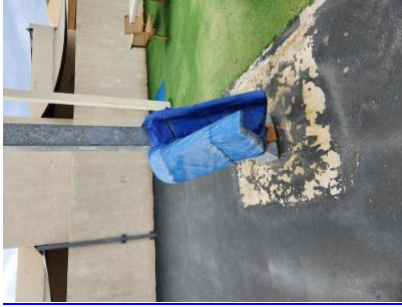
החצר תאורגן באופן שיבטיח בטיחות מרבית בעת תנועה ופעילות-1-מגרש כדורסל-הגנה על עמודי כדורסל לא תקינה. סכנת פציעה- - - 3.11-12/2/2023 21: 46-ארגון החצר.-של תלמידים
