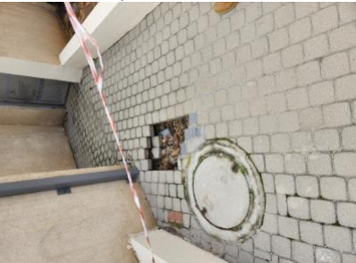
החצר תהיה נקייה 1-שביל ליד הכניסה של מוסד החינוך-אבנים משתלבות שקעו. בור קטן נפער באמצע השביל. סכנת נפילה- - - - 3.1-12/2/2023 21: 21-תשתיות-. ממפעי בטיחות קבועים או זמניים, ללא בליטות או שקעים, ולא יישארו בה מכשולים או פסולת מכל סוג . חלקים בולטים יהיו עם הגנה עליהם
