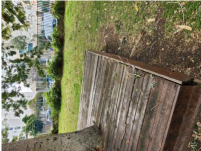
החצר תאורגן -1-חצרות מוסד החינוך-ספסל ישיבה מאולתר מעץ. האלמנטים של הספסל לא יציבים או מחוברים היטב. סכנת פציעה- - - - 3.11-17/2/2023 15: 52-ארגון החצר-באופן שיבטיח בטיחות מרבית בעת תנועה ופעילות של תלמידים
