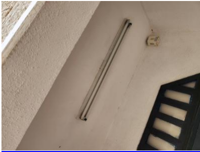
גופי תאורה יהיו -2-כיתות לימוד, חדרי ספח ומנהלה-גופי התאורה במוסד החינוך מסוג לא מוגן מפגיעה פיזית. מפגע גורף. סכנת פציעה- - - - 9.8-17/2/2023 15: 47-מנורות וגופי תאורה-מוגנים מפגיעה פיזית
