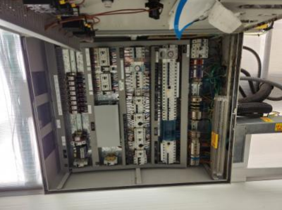
כל המעגלים ומפסקי -1-חממת חקר-מפסקים בלוח החשמל ללא סימון מתאים. כמו כן לא היה סידור נעילה מתאים ללוח החשמל- - - 7: 09 20/1/2023 9.3-לוחות חשמל- הזרם הראשיים יסומנו בסימון בר-קיימא
