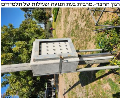
מטע/ שדה - לוח חשמל ללא מכסה בסמוך למטע ולשדות בחלק הצפוני . הלוח לא חשוף לגשם ואינו מוגן מים . סכנת התחשמלות- - - לוחות חשמל לא יהיו עשויים מחומרים דליקים, הארונות יהיו סגורים לארונות וללוחות יהיו סידורי נעילה. לא יהיו חלקים חשופים בלוחות. לא יהיו ארונות חשמל 1-בכיוון מזרח 9.1-20/1/2023 7: 28-לוחות חשמל-(ראשי/קומתי ואגפי) בצמוד לכיתות, מעבדות, משרדים וחדרי ספח מאוכלסים
