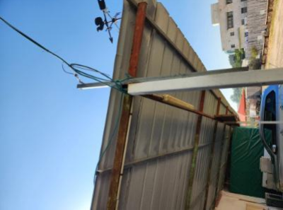
1-הסככה הצמודה לחניית הרכבים-כבל חשמלי ללא מוביל מתאים מחובר לסככה. הסככה עשויה ממתכת. קיימת סכנת התחשמלות- - - 6: 55 20/1/2023 9.9-חיווט וכבלי חשמל-כבלי חשמל קבועים יושמו בתוך תעלות מתאימות כבלי חשמל לא יהיו בהישג ידם של הילדים/תלמידים הדלתות תצוידנה באבזר או באבזרים לצורך המטרות הבאות: א. מגן אצבעות -1-חממת חקר. לא נמא סטופר לדלת הכניסה של החממה וגם לא בדלת האלומיניום הנוספת. סכנת פציעה- - - בשני צידי הצירים באזורים שבהם יש אפשרות להילכדות אצבעות. ב. האטת אגף הדלת במהלך סגירתו. ג. מעצור דלת במצב פתוח. האבזר יותקן בקיר, בגובה אגף הדלת ולא ברצפה. ד. במקלט 23-20/1/2023 5.23-דלתות- ובמרחב מוגן יש להתקין מגן אצבעות ואלמנט קיבוע שיותאם לדלת. ה. בדלתות קלות של שירותים נדרשת הגנה מתאימה
