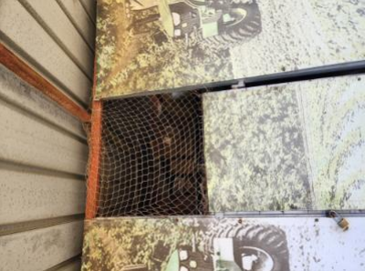
במחסן יהיה אוורור נאות -1-מחסן חומרי ההדברה-הסגירה מעל דלת המחסן לא מונעת כניסה של מבוגרים בצורה מתאימה- - - 7: 13 20/1/2023 30.5-- באמצעות פתחים בגובה של מטר וחצי לפחות מן הרצפה. בפתחים יותקנו סורגים למניעת הכניסה אל המחסן של מבוגרים וילדים, וכן תותקן רשת זבובים
