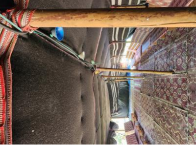
סככה - כבל חשמלי ללא תעלה מתאימה מחובר לסככה. הכבל בהישג יד של תלמידים. כמו כן גופי התורה אינם מוגנים מפגיעה פיזית- - - 6: 53 20/1/2023 9.9-חיווט וכבלי חשמל-כבלי חשמל קבועים יושמו בתוך תעלות מתאימות כבלי חשמל לא יהיו בהישג ידם של הילדים/תלמידים-1-בחלק הצפוני של המוסד
