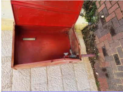
1- קיר חיצוני של אולם הספורט. ארון כיבוי האש נמצא עם פינות חדות. ארון כיבוי אש לא תקין. אין ציוד כיבוי אש מתאים בתוך הארון. - - - 4.2-4/2/2023 17: 19 ציוד ומטפי כיבוי אש. מיקום עמדות כיבוי אש יוצבו בצורה שאינה מסכנת את העוברים . הארונות יהיו שלמים ללא קצוות חדים. פתיחת הארון תהיה מהירה בכל מצב
