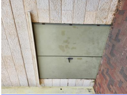
באולם הספורט תותקנה שתי דלתות, לפחות. 2-אולם הספורט. דלת האולם נעולה במנועל בזמן פעילות. מנגנון הבהלה לא נמצא תקין. - - - 11.2-4/2/2023 17: 26 דלתות. הרוחב המזערי הפנוי של כל דלת יהיה 1.10 מ'. רצוי הדלתות תיקבענה בקירות הנגדיים של האולם, כשהן רחוקות זו מזו ככל האפשר ופתחיהן כלפי חוץ, בכיוון המילוט
