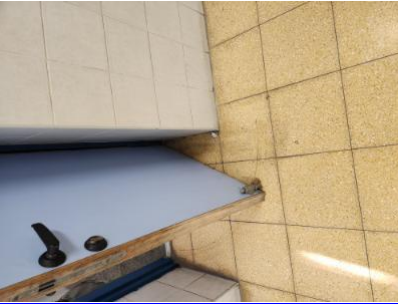
הידיות, המנעולים או חיפויים "(רוזטות)" -2-כיתה מספר : 22 וגם 13.-צילינדר דלת לא תקין. ידית דלת לא תקינה. סכנת פציעה והילכדות- - - 5.24-12/2/2023 18: 43-דלתות-.יהיו שלמים, חלקים וחופשיים מבליטת ברגים, פינים או חלקי פרזול אחרים
