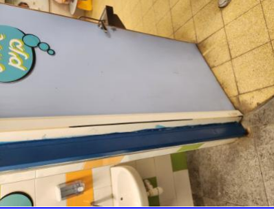
הדלתות תצוידנה באבזר או באבזרים לצורך -1-שירותי בנים בקומת קרקע-מגן אצבעות לא קיים/ לא תקין. סכנת פציעה באצבעות- - - המטרות הבאות : א. מגן אצבעות בשני צידי הצירים באזורים שבהם יש אפשרות להילכדות אצבעות. ב. האטת אגף הדלת במהלך סגירתו. ג. מעצור דלת במצב פתוח. האבזר יותקן בקיר, בגובה אגף 5.23-12/2/2023 18: 48-דלתות-.הדלת ולא ברצפה. ד. במקלט ובמרחב מוגן יש להתקין מגן אצבעות ואלמנט קיבוע שיותאם לדלת. ה. בדלתות קלות של שירותים נדרשת הגנה מתאימה
