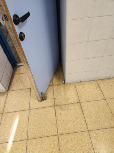
הדלתות תצוידנה באבזר או באבזרים לצורך -2-דלתות מוסד החינוך ( כיתות וחדרי הספח)-מעצור דלת לא קיים/ לא תקין. סכנת פציעה- - - המטרות הבאות : א. מגן אצבעות בשני צידי הצירים באזורים שבהם יש אפשרות להילכדות אצבעות. ב. האטת אגף הדלת במהלך סגירתו. ג. מעצור דלת במצב פתוח. האבזר יותקן בקיר, בגובה אגף 5.23-12/2/2023 18: 52-דלתות-.הדלת ולא ברצפה. ד. במקלט ובמרחב מוגן יש להתקין מגן אצבעות ואלמנט קיבוע שיותאם לדלת. ה. בדלתות קלות של שירותים נדרשת הגנה מתאימה
