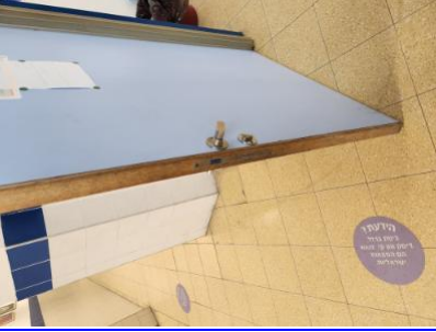
הידיות, המנעולים או חיפויים "(רוזטות)" -2-כיתה מספר : 22 וגם 13.-צילינדר דלת לא תקין. ידית דלת לא תקינה. סכנת פציעה והילכדות- - - 5.24-12/2/2023 18: 43-דלתות-.יהיו שלמים, חלקים וחופשיים מבליטת ברגים, פינים או חלקי פרזול אחרים
