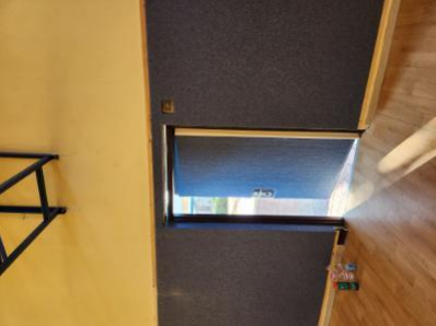
לא קיים רכיב כלשהו על דלת היציאה של האולם במטרה להאטת אגף הדלת בעת הפתיחה והסגירה. כמו כן לא נמצא רכיב מתאים - - - - הדלתות תצוידנה באבזר או באבזרים לצורך המטרות הבאות: א. מגן אצבעות בשני צידי הציירים באזורים שבהם יש -1-אולם הספורט- לתפוס את הדלת בסוף תנועתה ולהצמיד אותה לקיר אפשרות להילכדות אצבעות. ב. האטת אגף הדלת במהלך סגירתו. ג. מעצור דלת במצב פתוח. האבזר יותקן בקיר, בגובה אגף הדלת ולא ברצפה. ד. במקלט ובמרחב מוגן יש להתקין מגן
