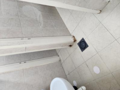
לא יהיו מפגעי תשתית בבניין -1-שירותי בנות/ שירותי בנים בקומת קרקע- משקופי דלתות מתכתיות חלודים. סכנת פציעה- - - - 5.10-19/1/2023 21: 57 מפגעים קבועים וניידים- ובכיתות ובפרט סדקים במבנה, רצפות שקועות, סימני רפיון (כגון "בטן") בתקרות תלויות ומפגעי תשתית אחרים
