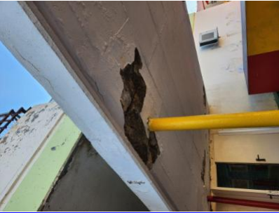
לא יהיו -2-מעבר אחורי בכיוון אולם הספורט- טיח מתפורר בתקרת המעבר. איטום לא תקין של הגשר במעבר אל אולם הספורט- - - - 5.10-19/1/2023 21: 45 מפגעים קבועים וניידים- מפגעי תשתית בבניין ובכיתות ובפרט סדקים במבנה, רצפות שקועות, סימני רפיון (כגון "בטן") בתקרות תלויות ומפגעי תשתית אחרים
