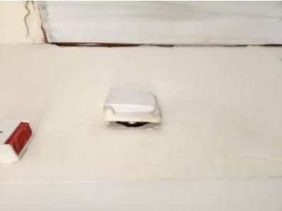
כל אביזרי החשמל יהיו שלמים ומקובעים 0-חדר מספר 15-מפסק חשמל לא מקובע למקומו בצורה תקינה. חוטי חשמל חשופים- - - - 9.5-7/2/2023 5: 19 מפסקים ושקעים-למקומם
