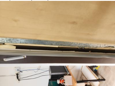
הדלתות תצוידנה באבזר או באבזרים לצורך המטרות הבאות: א. מגן אצבעות בשני צידי 1-חדר המוסיקה-מגן אצבעות לא תקין- - - - 5.23-7/2/2023 5: 22 דלתות-מוגן יש להתקין מגן אצבעות ואלמנט קיבוע שיותאם לדלת. ח. בדלתות קלות של שירותים נדרשת הגנה מתאימה הציירים באזורים שבהם יש אפשרות להילכדות אצבעות. ב. האטת אגף הדלת במהלך סגירתו. ג. מעצור דלת במצב פתוח. האבזר יותקן בקיר, בגובה אגף הדלת ולא ברצפה. ד. במקלט ובמרחב
