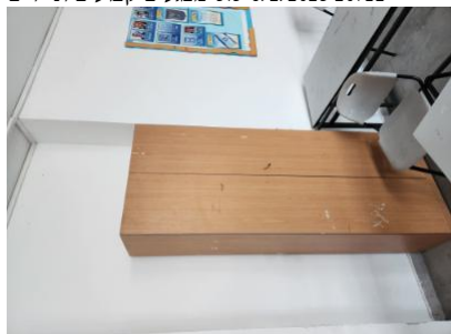
- ארונות, ספרייות וכונניות יהיו מקובעים למניעת התהפכות-1-חדרים 159 / 161 / 165 / 178. מפגע גורף-ארונות לא מקובעים לקיר- - - 20: 12 5-5-6/2023 מפגעים קבועים וניידים
