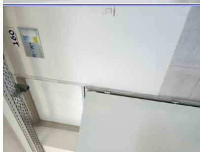
-1-חדרים 160 / 165 / 166 / 167.. מפגע גורף- נמצאו דלתות שנפתחות 180 מעלות. לא הותקן מגן אצבעות בצידה החיצוני של הדלת- - - הדלתות תצוידנה באבזר או באבזרים לצורך המטרות הבאות: א. מגן אצבעות בשני צידי הצירים באזורים שבהם יש אפשרות להילכדות אצבעות. ב. האטת אגף הדלת במהלך סגירתו. ג. מעצור דלת במצב פתוח. האבזר יותקן בקיר, בגובה אגף הדלת ולא ברצפה. ד. במקלט ובמרחב מוגן יש להתקין מגן אצבעות ואלמנט קיבוע שיותאם לדלת. ה. בדלתות קלות של שירותים 5-23-6/2023 20: 19 דלתות- נדרשת הגנה מתאימה
