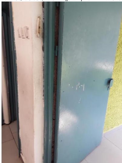
הדלתות תצוידנה באבזר או באבזרים לצורך המטרות -1-דלת כניסה ראשית מבנה כתות ז ללא מגן אצבעות-חוסר במגן אצבעות- - - 8:09 5.23-2/3/2023 דלתות- הדלת ולא ברצפה. ד. במקלט ובמרחב מוגן יש להתקין מגן אצבעות ואלמנט קיבוע שיותאם לדלת. ה. בדלתות קלות של שירותים נדרשת הגנה מתאימה הבאות: א. מגן אצבעות בשני צידי הצירים באזורים שבהם יש אפשרות להילכדות אצבעות. ב. האטת אגף הדלת במהלך סגירתו. ג. מעצור דלת במצב פתוח. האבזר יותקן בקיר, בגובה אגף
