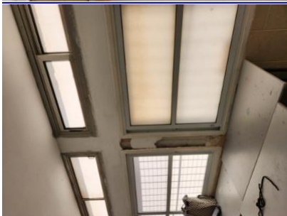
לא יהיו מפגעי תשתית בבניין ובכיתות ובפרט סדקים במבנה, רצפות שקועות, -2--חדר 06- קומה 1.-חלקי טיח שהתפרקו מהקיר- - - 5.10-28/1/2023 15: 25- מפגעים קבועים וניידים.- סימני רפיון (כגון "בטן") בתקרות תלויות ומפגעי תשתית אחרים
