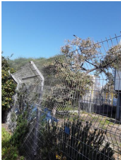
בכל חלקי הגדר לרבות החלק העליון, לא יהיו -2-גדר המוסד-חלק מהגדר בנויה מגד רשת עם אלמנטים מחדים בחלק העליון- - - 21: 9: 2/3/2023 3.30-גדר-אלמנטים חדים המהווים סכנת פציעה לילדים המסתובבים בסביבתה או מטפסים עליה
