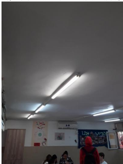
מנורות וגופי - גופי תאורה יהיו מוגנים מפגיעה פיזית-1-כתות מבנה מרכזי -גורף בכל בית הספר-חלק מגופי התאור לל מכסה מגן- - - 28: 9: 2/3/2023 9.8-תאורה
