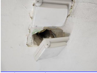
כל אביזרי החשמל -0-חדר 04 בקומה מינוס 1.-מפסק חשמל לא מחובר במקום. חוטי חשמל גלויים בהישג יד. סכנת התחשמלות- - - 9.5-28/1/2023 15: 28- מפסקים ושקעים.- יהיו שלמים ומקובעים למקומם
