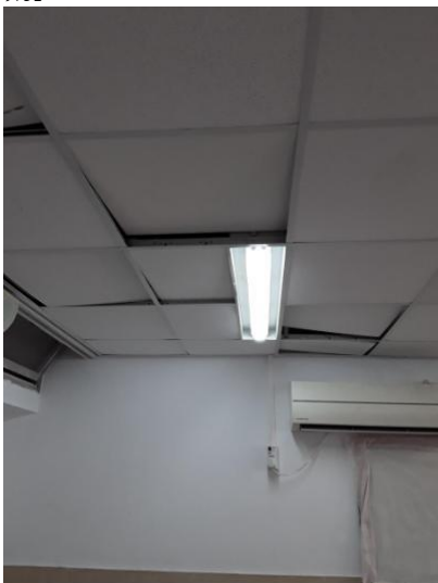
לא יהיו מפגעי תשתית בבניין ובכיתות ובפרט סדקים במבנה, 1-כתות עם תקרה מינרלית-יחידות מינרליות מחוץ לתושבת- - - 10-2/3/2023 9: 55-5-מפגעים קבועים וניידים-רצפות שקועות, סימני רפיון (כגון "בטן") בתקרות תלויות ומפגעי תשתית אחרים
