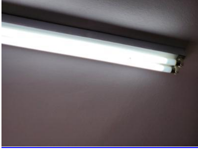
גופי תאורה יהיו מוגנים מפגיעה -1-כיתה 04 - קומה 1- / כיתה 30 - קומה 2+ / מפגע גורף-גופי תאורה לא מוגנים מפגיעה פיזית- - - 9.8-28/1/2023 15: 31- מנורות וגופי תאורה.- פיזית
