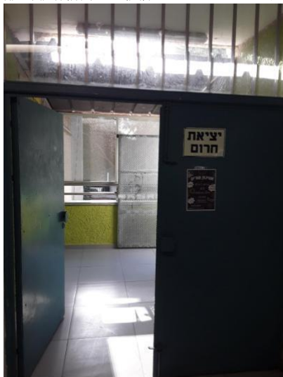
בחלל/חדר שתפוסתו 100 איש ומעלה נדרש להתקין מנעול בהלה. אם -1-מבנה כתות ז/ספרייה-דלת היציאה ללא מנגנון בהלה- - - 8:06 4.14-2/3/2023 הכנה למילוט-ישנן מספר כנפיים לדלתות – בכל כנף יותקן מכלול נעילה למנעול בהלה
