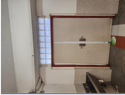
בחלל /חדר -2-יציאות חירום במוסד החינוך-יציאת החירום ללא מנגנון בהלה מתאים. אין מוכנות מספקת לשעת חירום- - - 4-14-4/3/2023 22: 38 הכנה למילוט-שתפוסתו 100 איש ומעלה נדרש להתקין מנעול בהלה. אם ישנן מספר כנפיים לדלתות – בכל כנף יותקן מכלול נעילה למנעול בהלה
