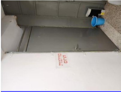
בחלל /חדר -2-יציאות חירום במוסד החינוך-יציאת החירום ללא מנגנון בהלה מתאים. אין מוכנות מספקת לשעת חירום- - - 4-14-4/3/2023 22: 38 הכנה למילוט-שתפוסתו 100 איש ומעלה נדרש להתקין מנעול בהלה. אם ישנן מספר כנפיים לדלתות – בכל כנף יותקן מכלול נעילה למנעול בהלה
