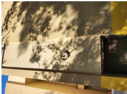
גופי התאורה -2-. גוף התאורה על הקיר החיצוני בחצר האחורית - מעל דלת היציאה-גוף התאורה לא נמצא שלם/ מוגן מים - - - 9.7-27/1/2023 19:48 -מנורות וגופי תאורה-בחדרי השירותים ובחצר יהיו מטיפוס מוגן-מים
