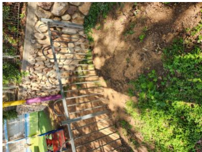
גובה המעקה מעל חללים פתוחים יהיה 1.20 מטר לכל -2-חצר אחורית-מעקה בטיחות בגובה 70 ס"מ סכנת טיפוס ונפילה- - - 5.38-27/1/2023 20: 51-מעקים ומסעדים-הפחות ולא יאפשר כל טיפוס
