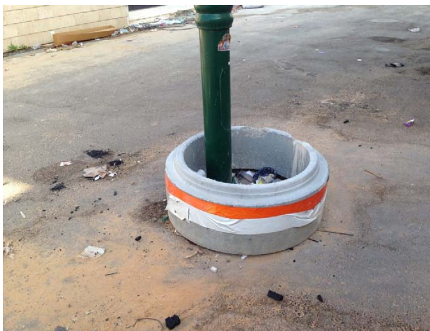
אי סלילת כביש ומדרכות ברחובות תרשיש, נופך וגביש.
